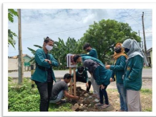
Gambar 2. Pemasangan Plang Jalan
